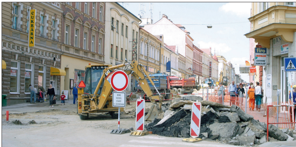
Rekonstrukce tř. 9. května má své příznivce i odpůrce. V debatách o vzhledu ulice se někdy vytrácí základní důvod oprav v podobě nevyhovujících inženýrských sítí. Stav kanalizace například již neumožňoval ani prohlídku kamerou a stav vodovodu se jasně projevil při zahájení prací. Každý pohyb v okolí potrubí znamená poruchu a přerušeni dodávky vody. Plynovod umožní ekologické vytápění objektů na této hlavní tábořské obchodní třídě.
