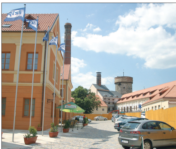
Rekonstrukce areálu hradu Kotnova pokračuje nebyvalým tempem. Vedle dokončení objektu ve vstupní části probíhají intenzivní práce i v dalších objektech. Celková letošní investice se bude blížit 50 milionům korun a město se bude podílet částkou 4 milionů korun. Jen za prvních pět měsíců bylo v areálu postaveno více než 20 milionů korun.
